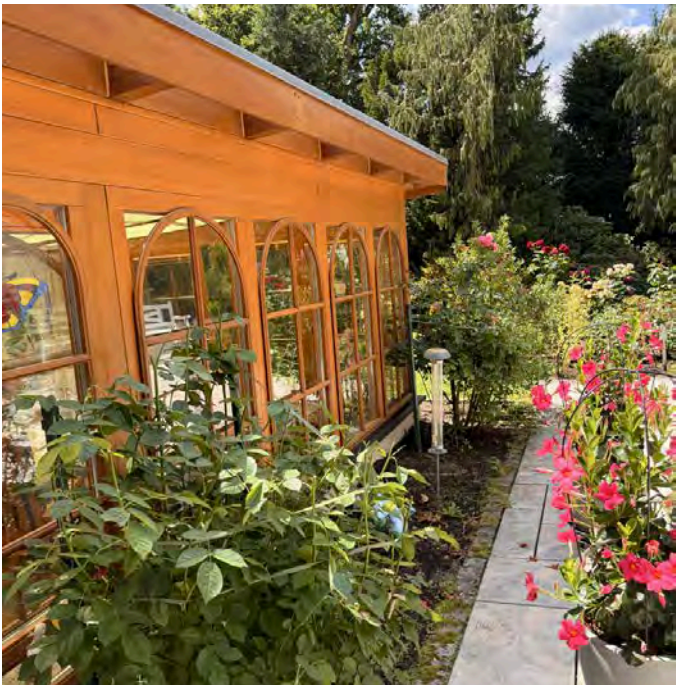
Wintergarten an der Terrasse
