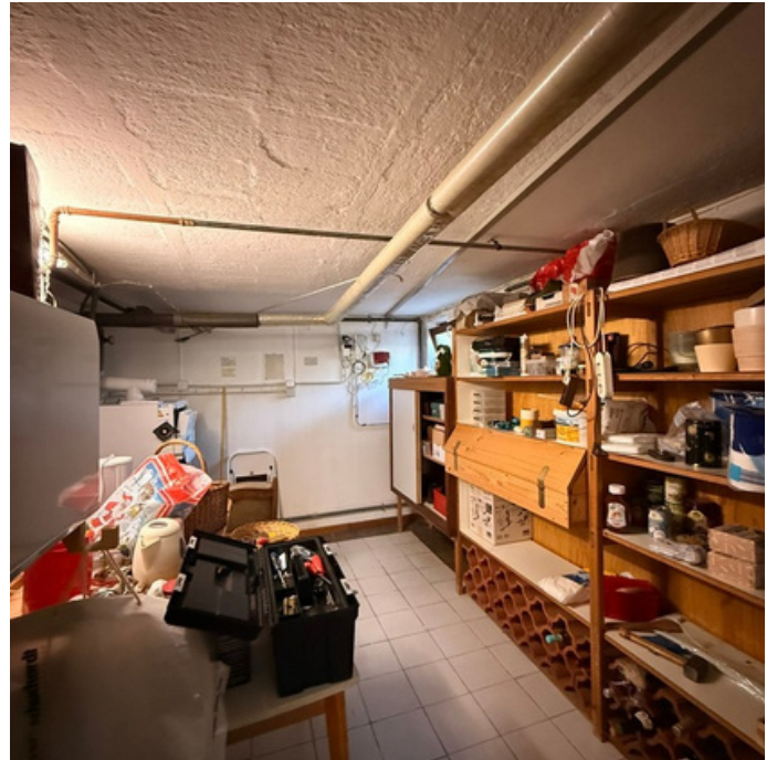
Heizungsraum und Abstellraum
