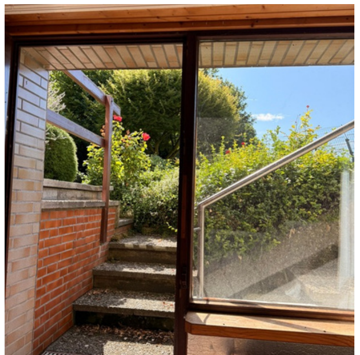
Ausgang hinteres Zimmer (ehem. Garage)
